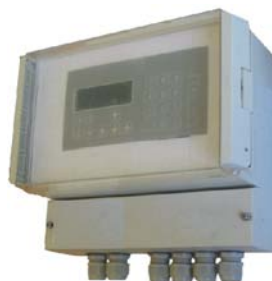
Блок контроля и управления БУК-01
